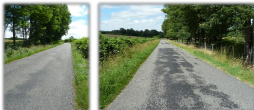
La RD 34 au droit de l'aire d'étude
